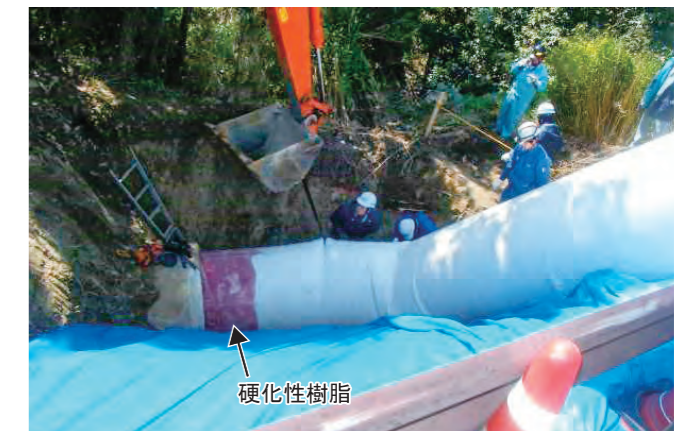
写真2 施工状況（発進側管口）
