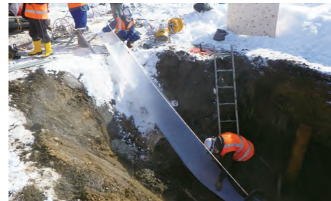
写真1 スリップシート設置工
