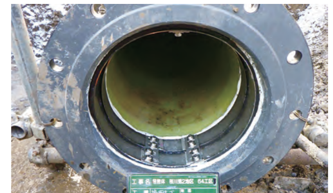
写真7 端末処理工
