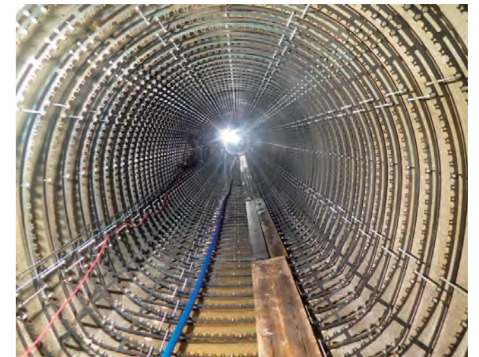
写真1 鋼製リング組立
