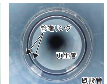
写真4 管端処理状況
