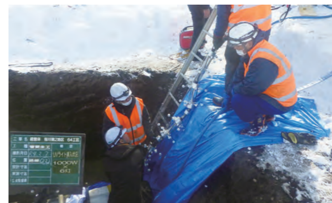
写真3 光照射装置挿入工
