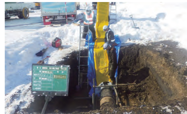
写真2 更生材引込工
