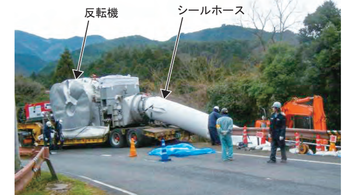
写真1 施工状況（地上）
