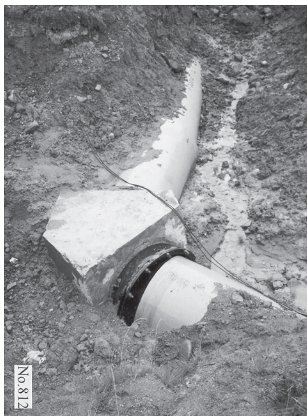
図6 地震動によってズレと破損を生じた管路
