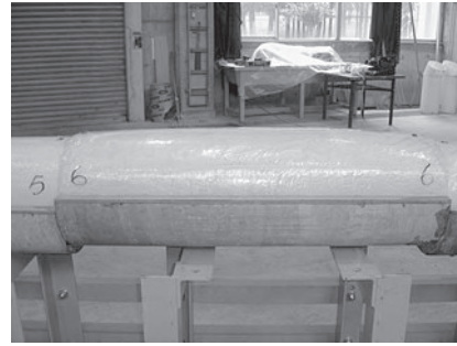
段差部の施工状況（段差 3cm）
