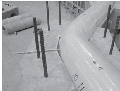
曲管の施工状況
