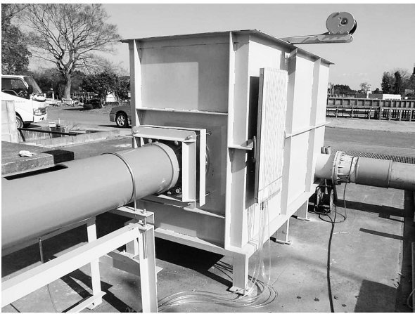
写真-4 マノメータ（水槽側面）
