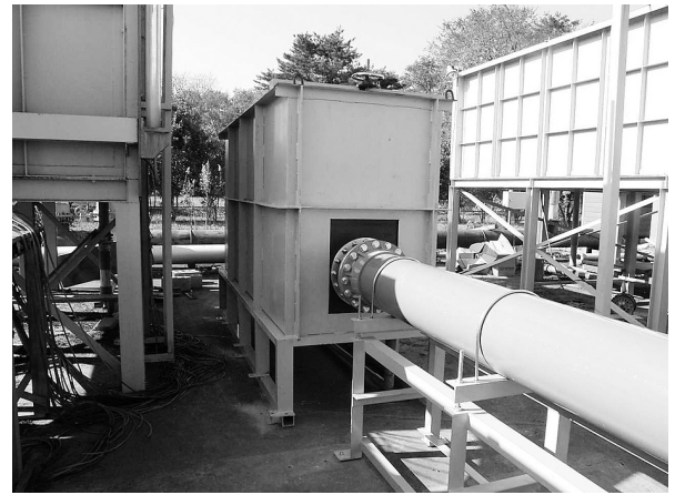
写真-1 上流整流水槽
