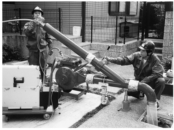
（参考）施工事例
