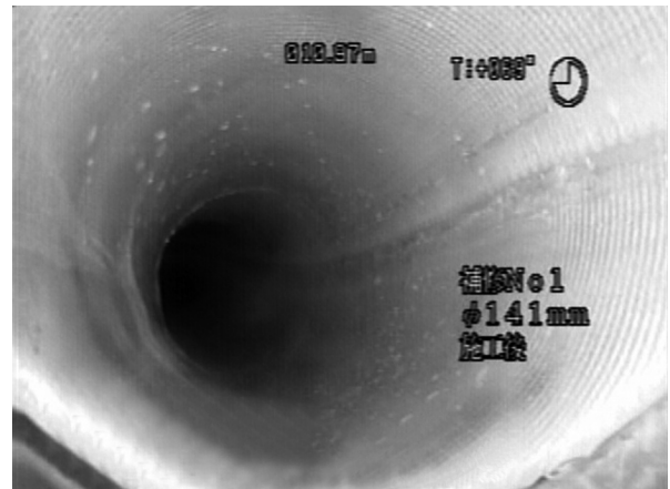
(参考) 取付管更生施工後
