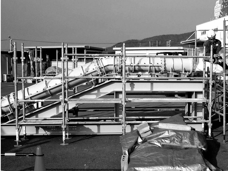
写真－3 曲管部（上下方向）
