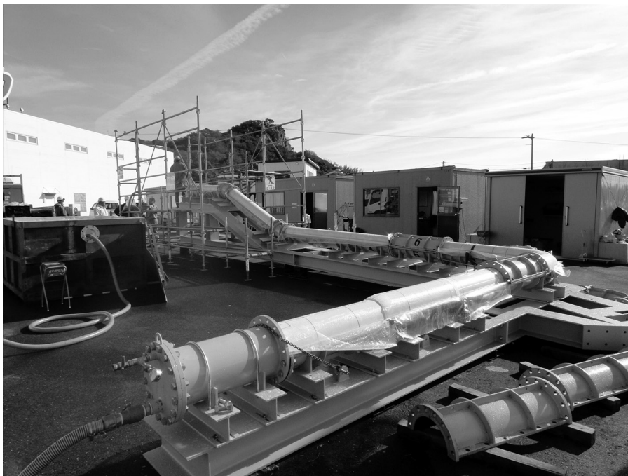
写真一一 外観検査
