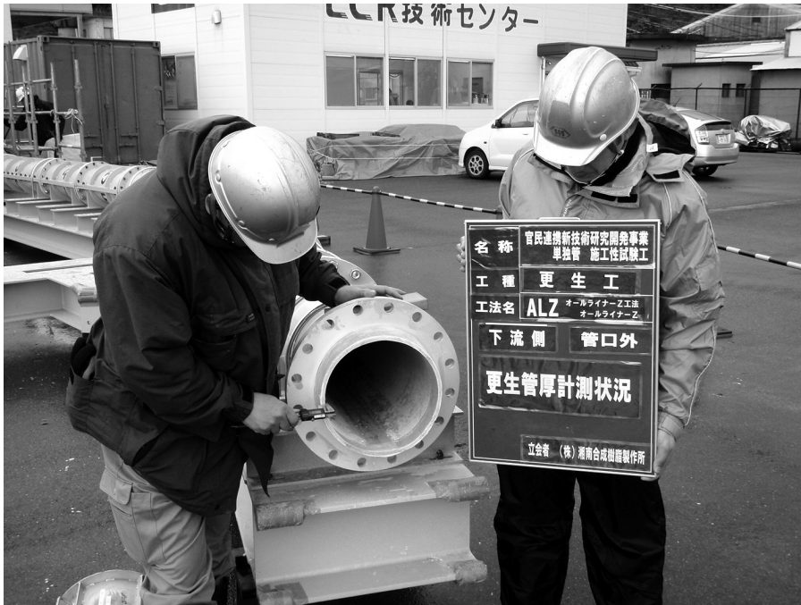
写真一〇 出来形計測
