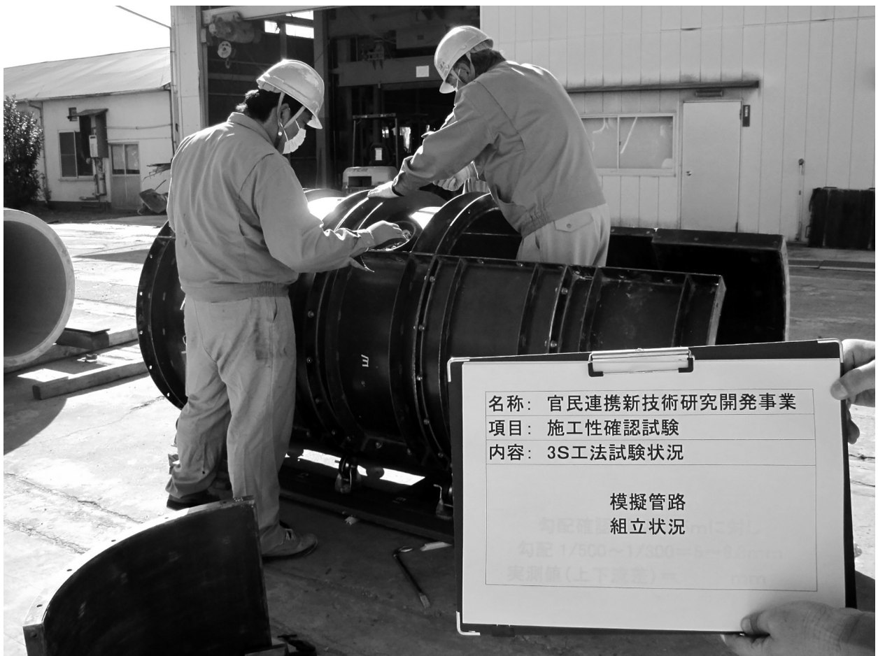
写真-1 模擬管路組立状況
