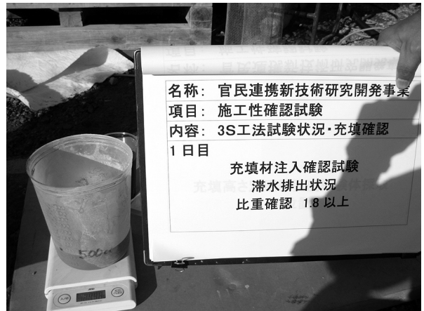
滞水排出比重測定状況
