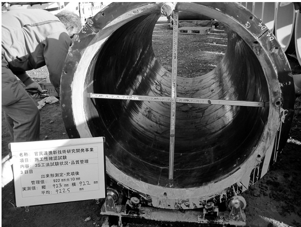
出来形管理 充填後の測定状況
