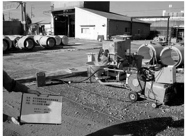
充填機材設置状況
