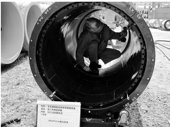
更生部材組立状況
