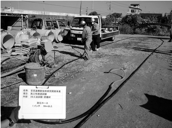
写真-2 充填ホース設置状況
