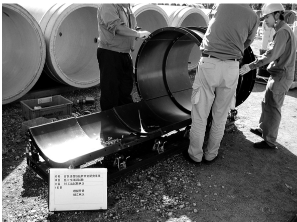
模擬管路組立状況
