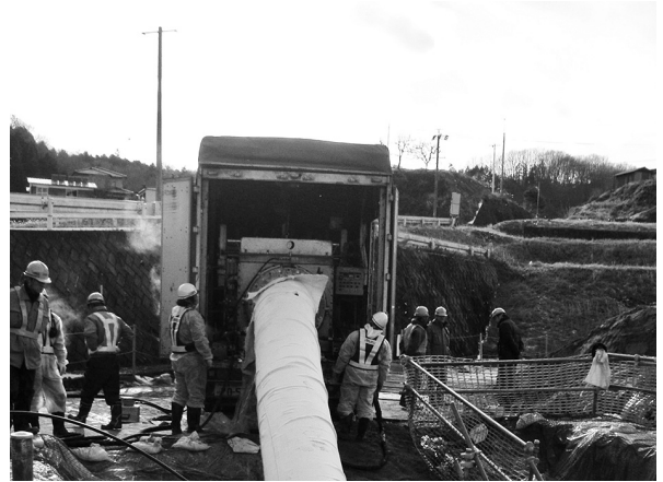
反転施工風景
