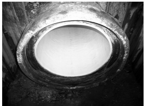
硬化養生後管口
