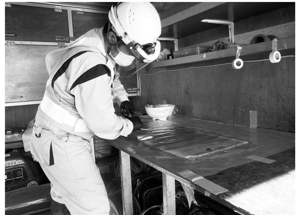
写真4 ライニング材への含浸作業
